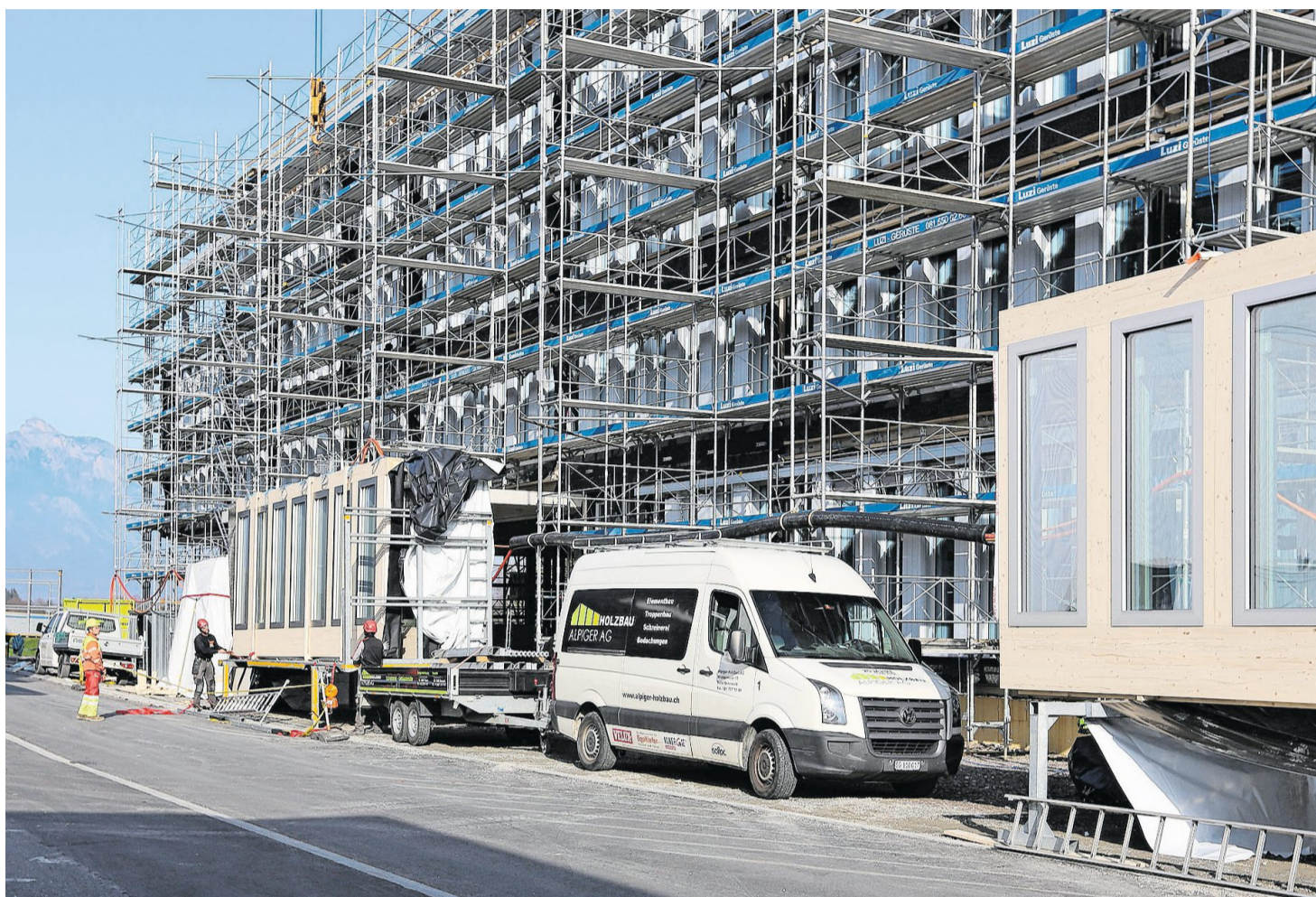
Bis Ende Jahr wird die Gebäudehülle mehr oder weniger dicht sein.
