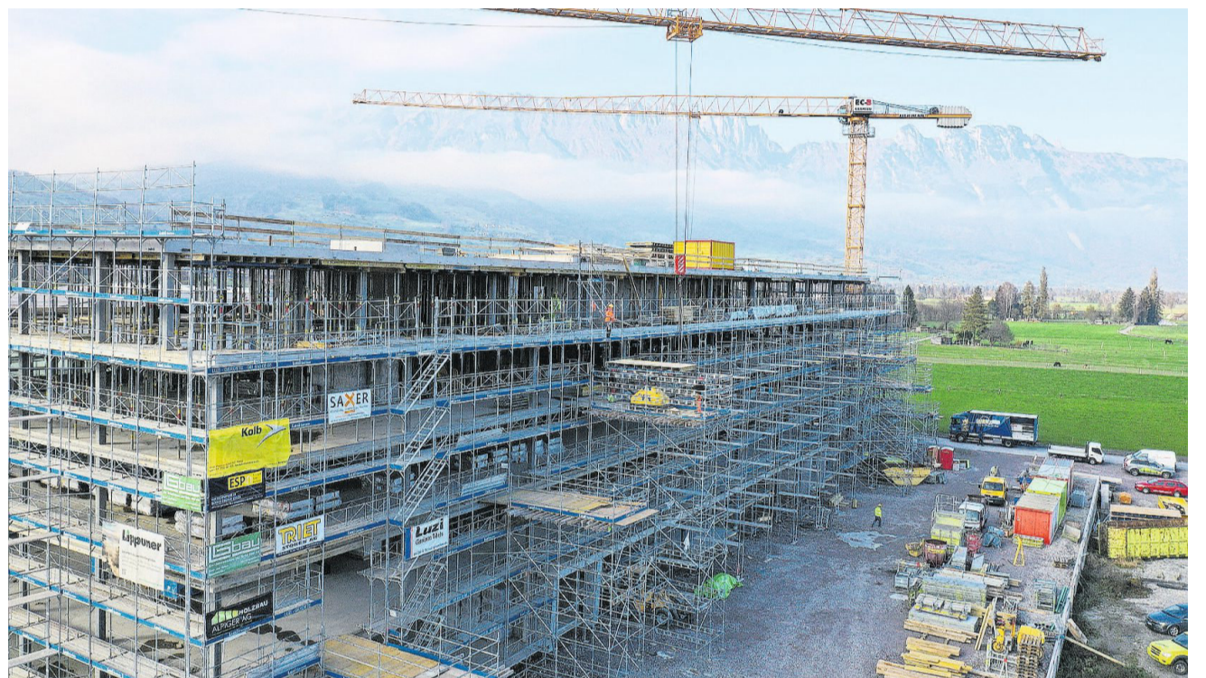
Der Rohbau ist fertig. Vor einer Woche begann die Montage der vorgefertigten Fassadenelemente aus Holz. Bild: PD
