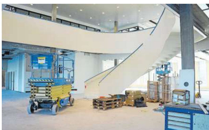
Hier entsteht der künftige Empfangsbereich.
