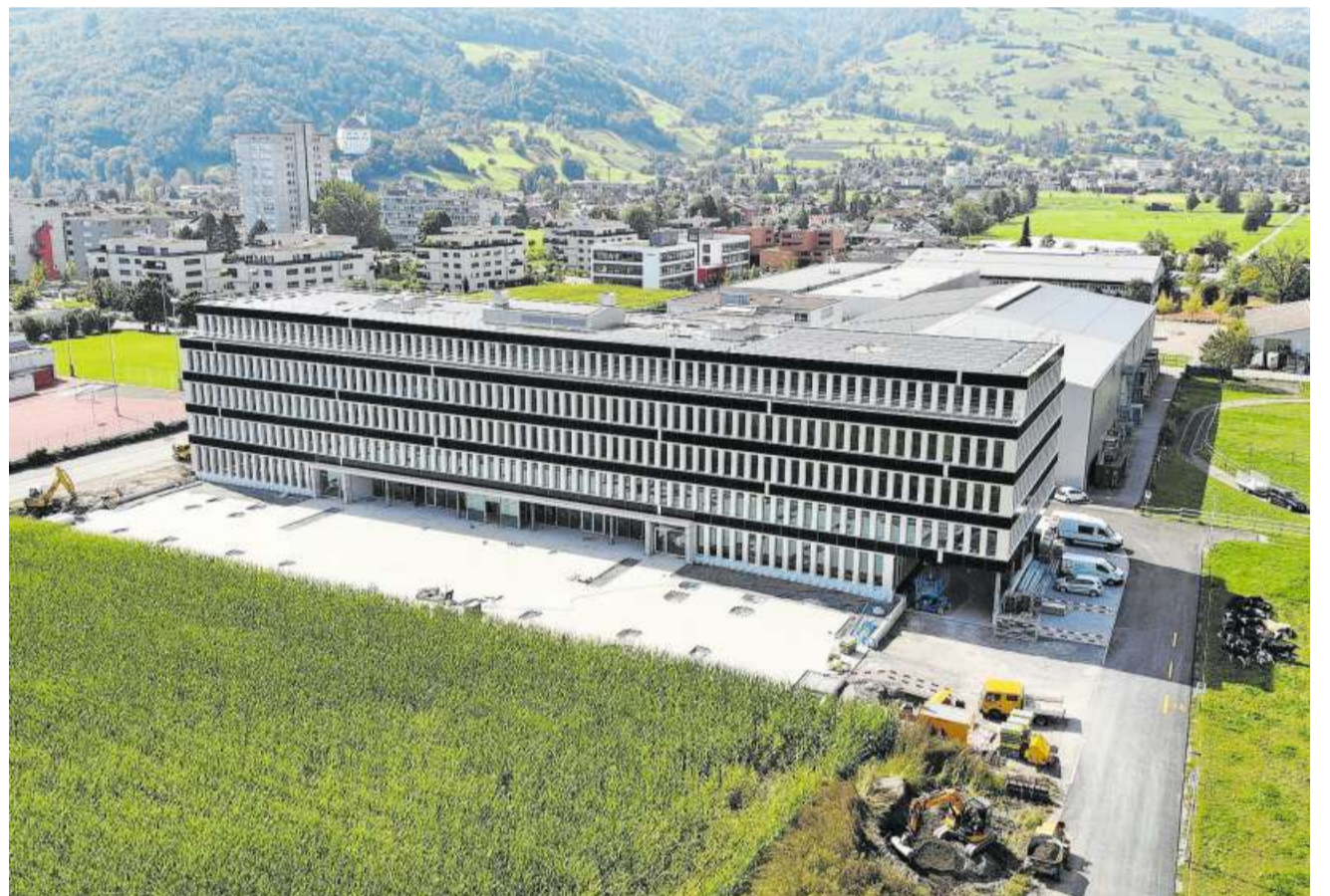
Noch sind auf dem Areal Fegeren Arbeiten im Gange.
